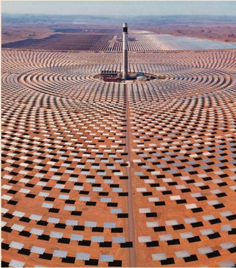
Gli impianti. Uno degli impianti di generazione di Acwa Power in Marocco
